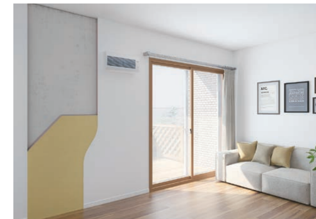
内張断熱ボードによる断熱改修
