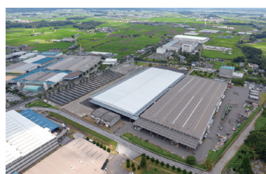
パナソニック ホームズ湖東工場の新建屋
