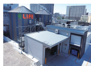
バイオガス発電を導入いただいた、(株)ライフコーポレーションの総菜工場
