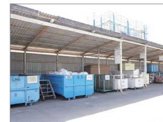
産業廃棄物は細かく分別し屋根のあるところに保管(パナソニック ホームズ事例)
