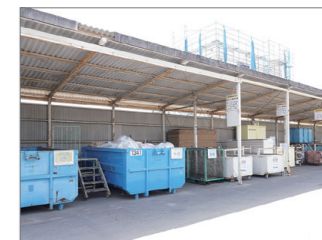
産業廃棄物は細かく分別し屋根のあるところに保管(パナソニック ホームズ事例)
