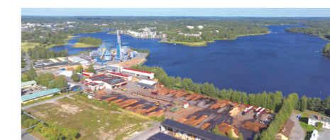
ミサワホームズ オブ フィンランドと隣接する火力発電所
