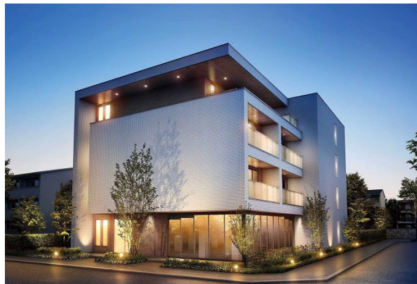
IoT賃貸住宅『ユアメゾン』外観 イメージ
