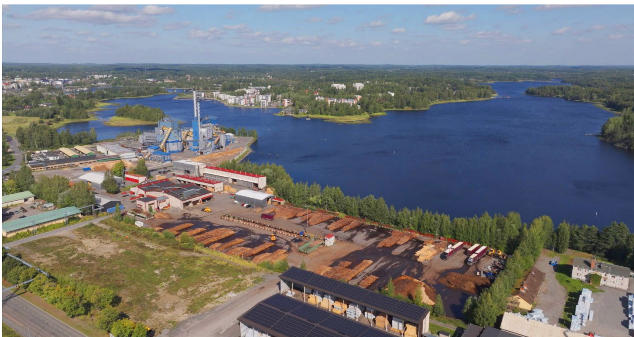
フィンランド最大のサイマー湖の湖岸に立地する ミサワホームズ オブ フィンランドと隣接する火力発電所
