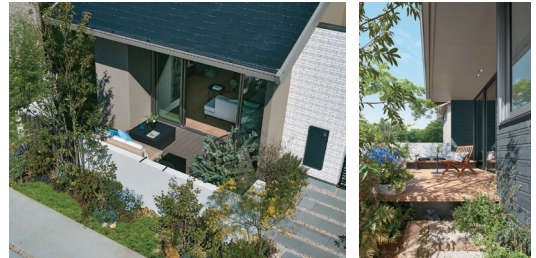
塀や植栽の連続によって防犯性を高める 「セキュリティ外構」
