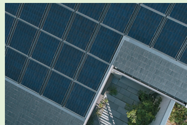
大容量の太陽光発電システムを搭載できる 「大屋根エコフォルム」
