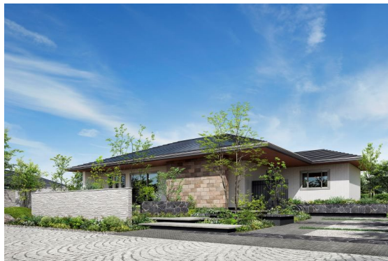
『カサート平屋 断熱等級7モデル』外観イメージ
