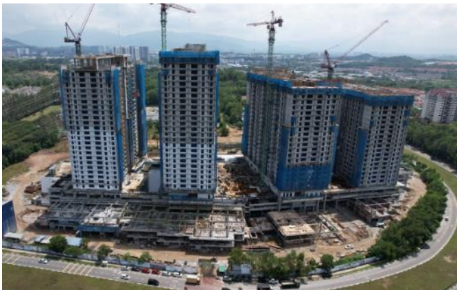
建設中の様子
