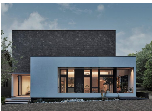
まちの景観となる洗練された外観
