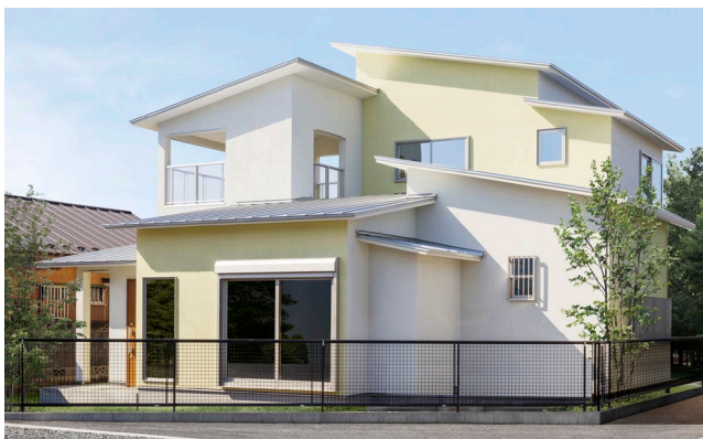
厳しい斜線制限に対応した外観
