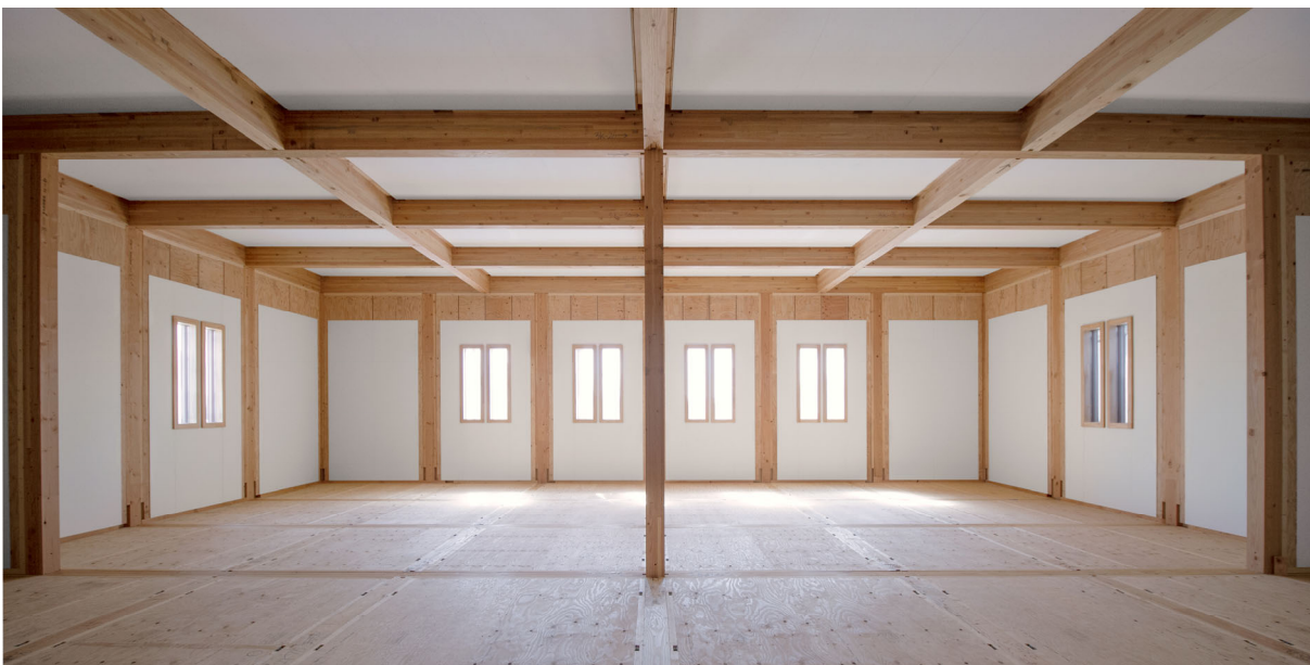
「夏期隊員宿舎」3階の食堂の一部（造作工事前の様子）
