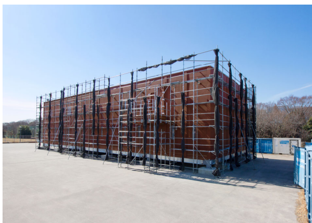
国内での仮組み立て工事（2・3階 木造部）
