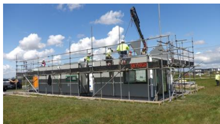
建築中の様子
